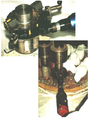
Découpe des tubes guides des barres de contrôle
