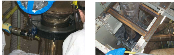
Découpe des tuyaux du circuit primaire
