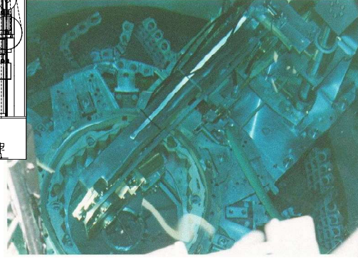
Scie à ruban sous eau à distance (1ère mondiale !)
