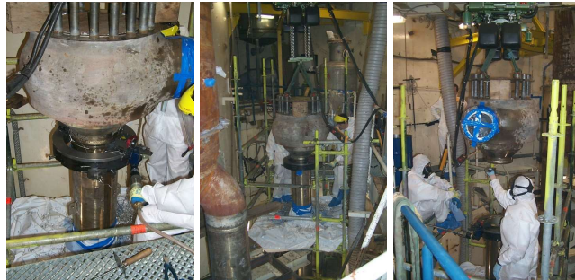
Découpe des tuyaux du circuit primaire
