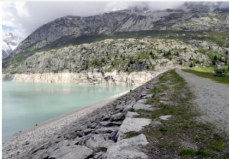
Barrage à enrochement
